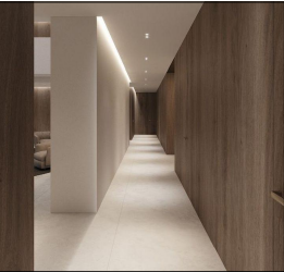
Panelado de chapa de madera de roble
